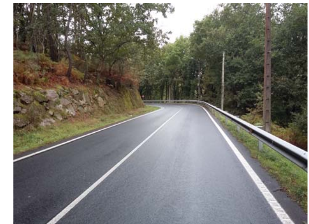
Muro de protección de escollera del talud de desmonte existente a la altura del p.k. 2+330, donde cruza bajo la vía la línea de gas
