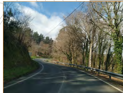
ELECTRICIDAD / ALUMBRADO POSTES AFECTADOS
