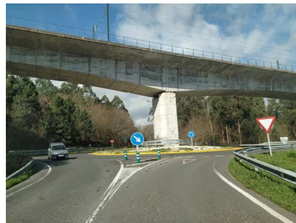
Intersección en glorieta entre antigua AC-299 y AC-301
