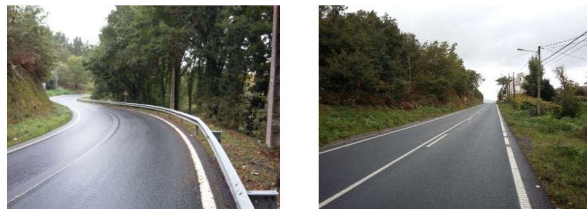
Fotografías tramo de actuación
