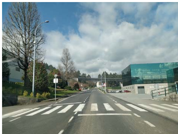
Vista de la zona de inicio de la actuación
